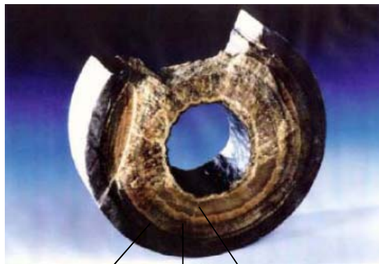
Scale i gassproduksjonsrør
